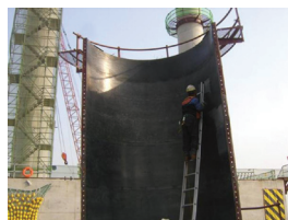
4. 거푸집 청소 • 거푸집 표면에 부착된 녹, 이물 질 등을 그라인더를 이용하여 제거(4hr/1개소)
