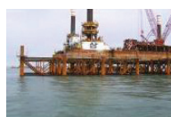
2. 작업대(Jig-Jacket) 설치 • 핀-파일(Pin-Pile)을 타입하여 작업대 고정
