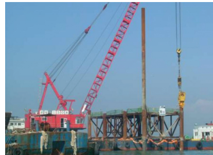
> Pin Pile 설치
