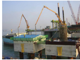
5-1. 콘크리트타설 • 한중콘크리트 타설 시 보온 양생용 House를 설치한 후 4단으로 분리타설 (6hr/1개소)
