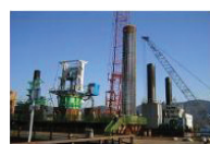
9. 철근망 제작 및 근입 • 육상제작 철근망을 해상으로 운반 • Roll-Up Frame으로 철근망을 세워 설치
