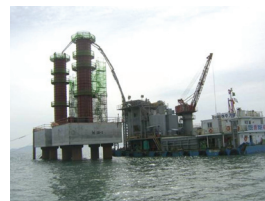
6. 콘크리트 타설 • 해상 BP를 해당구간에 접안하여 타설(1.5hr/1개소)
