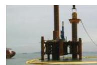
3. 강관 1차 타입 • 말뚝 중심위치 측량 • 가이드 프레임 설치하여 정위치로 조정 *수평허용편차 75mm
