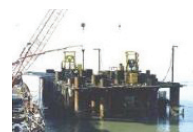
11. 콘크리트 타설 • 해상 배치플랜트(BP)와 트레미관으로 연속 타설 • 말뚝 건전도 검사 (공대공 초음파 검측)
