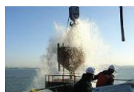
10. 슬라임 제거 • 맑은 물이 배출될 때까지 에어 리프팅 실시 • 1차 : RCD굴착 종료시 • 2차 : Con'C 타설 직전
